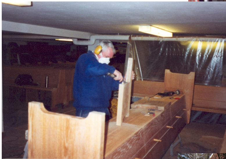
Bänkerestauration in der Garage
